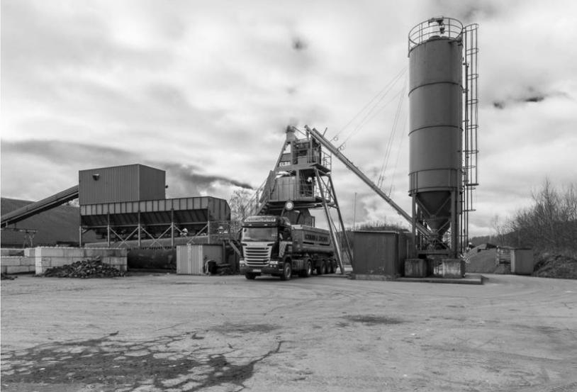
Die SAV behandelt und verwertet am Standort Schlewecke teerhaltigen Asphalt aus welchem hydraulisch gebundene Tragschichten (HGT) sowie qualifizierter Deponieersatzbaustoff hergestellt werden.
